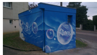
« Rénovation d'un transformateur électrique »
